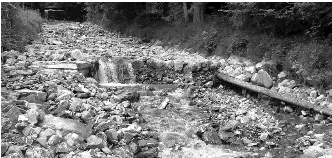
Abb. 1: Zerstörungen nach dem Hochwasser 2007 (Aufnahmen August 2008).
