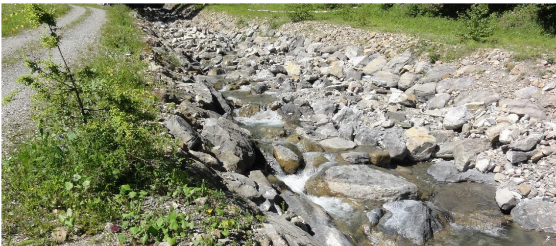
Abb. 5: Ansicht Steinbach fünf Jahre nach Instandstellung (Aufnahme Juni 2021).
