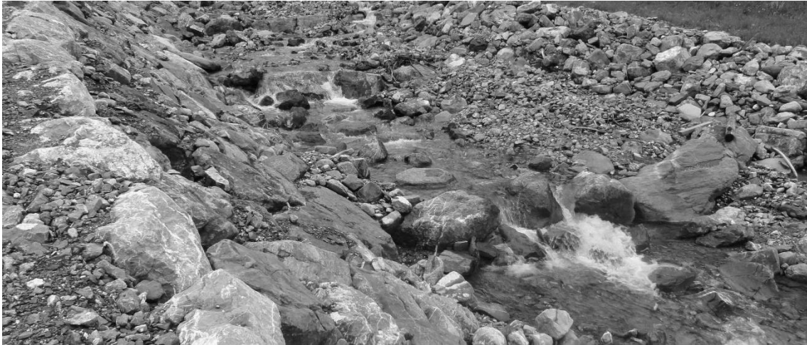
Abb.4: Ansicht Steinbach nach Ausführung Stufen-Becken-Abfolge (Aufnahme Mai 2013).
